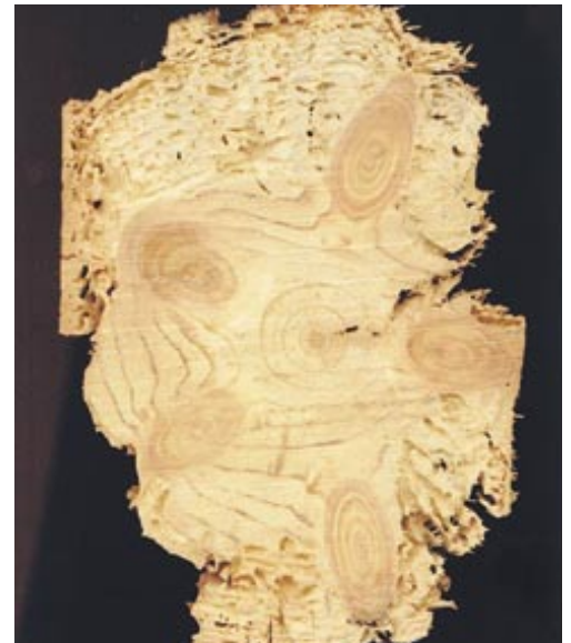
Abb. 5. Dachbalken mit Hausbockkäferbefall (Querschnitt).
